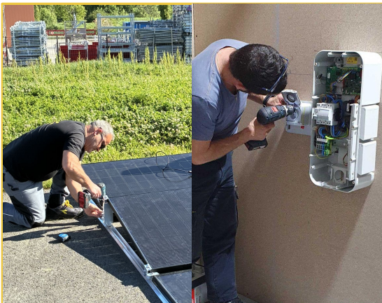
Installateur de panneaux photovoltaïques et bornes de recharge électriques (PV + IRVE)
